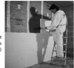
Isolant seul + parement rajouté après (isolation derrière contre-cloison)
