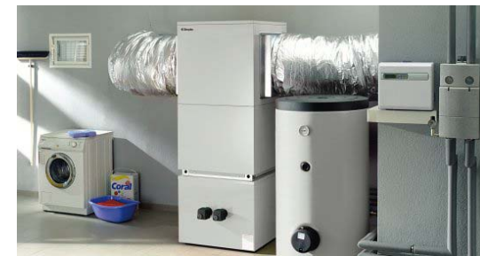
PAC + plancher ou radiateurs à eau
