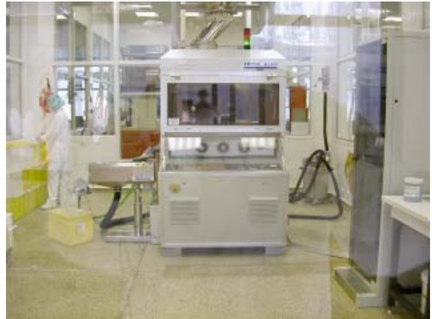
Les nouvelles installations du Multi Product Plant de Chinoïn
